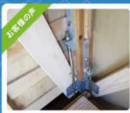
田野町 Y様 着工から完成まで一切手抜きナシの工事でした。頼んでよかったです!!
