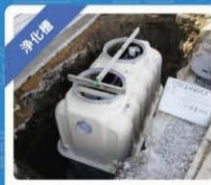
浄化槽工事 浄化槽工事もできます。 補助金をもらって工事もできます。
