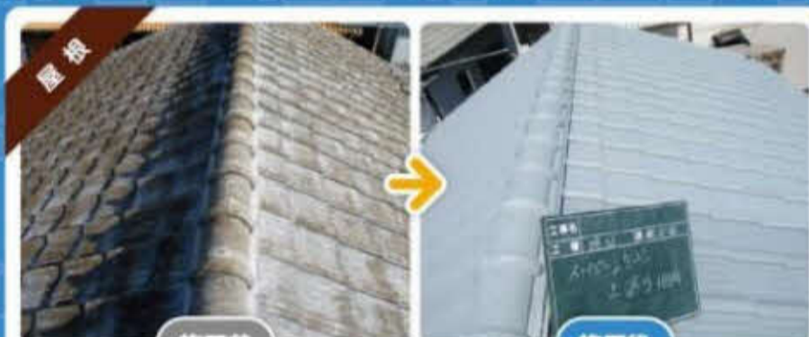
田野町 A様 海岸に近い住宅で塩害が進んでいました。塩害に強い塗料を選択し、建物の寿命を延ばすのに成功しました。
