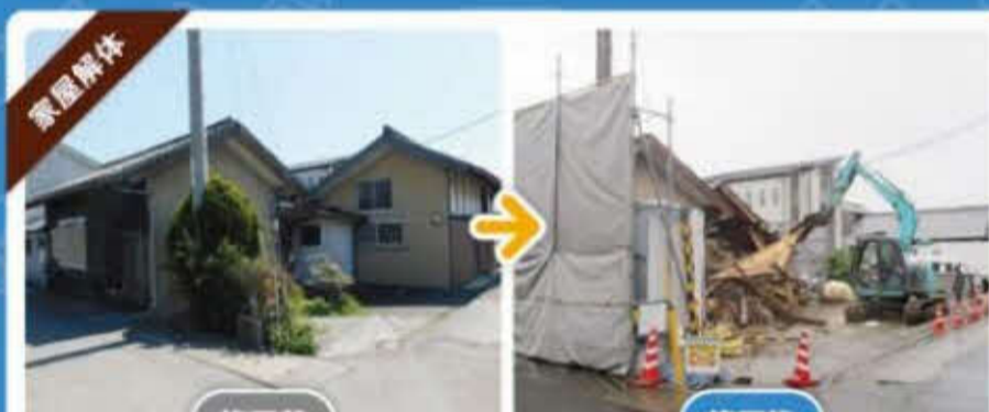
香南市 K様 老朽化してしまった家でしたが、地震や台風で近所に瓦やトタンが飛んでいかないか心配でしたが、安心しました。
